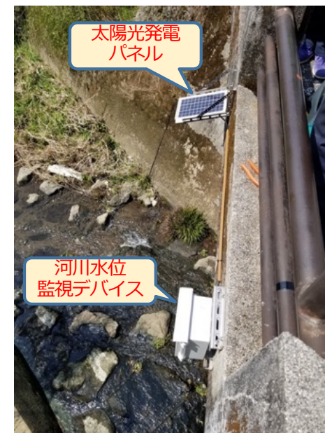
現場設置事例
