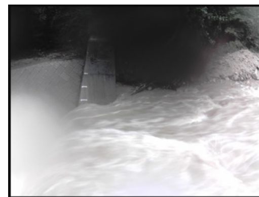
台風時に捉えた砂防ダムの写真（事例）
