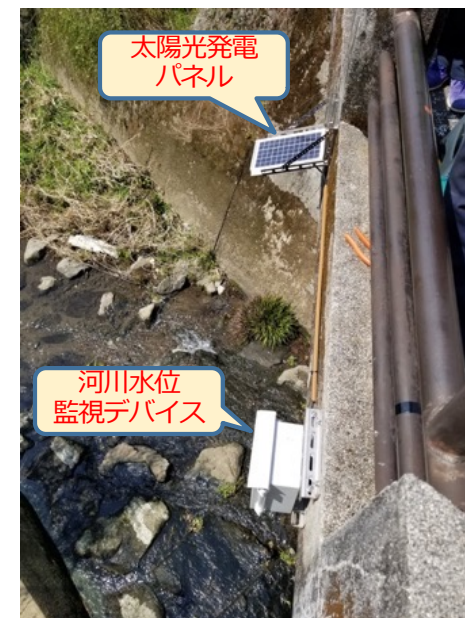
現場設置事例
